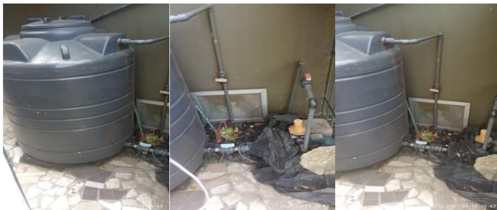
Planche 2 : Installation de fût rattaché à un supprimeur Cliché : Aké-Awomon, 2021
