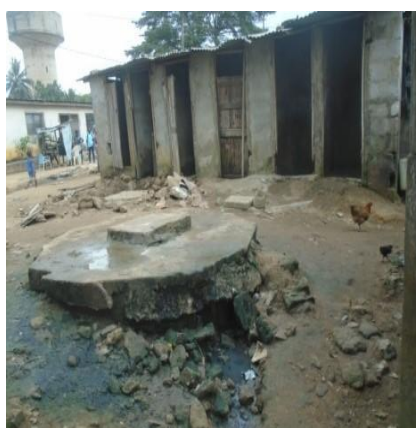
Photo2 : Une fosse septique utilisée par plusieurs ménages dans le quartier de Port Bouët 2 (Prise de vue: Bakary N. Mathieu, 2022)
